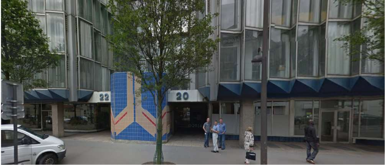
Rue du Château des Rentiers, Paris
